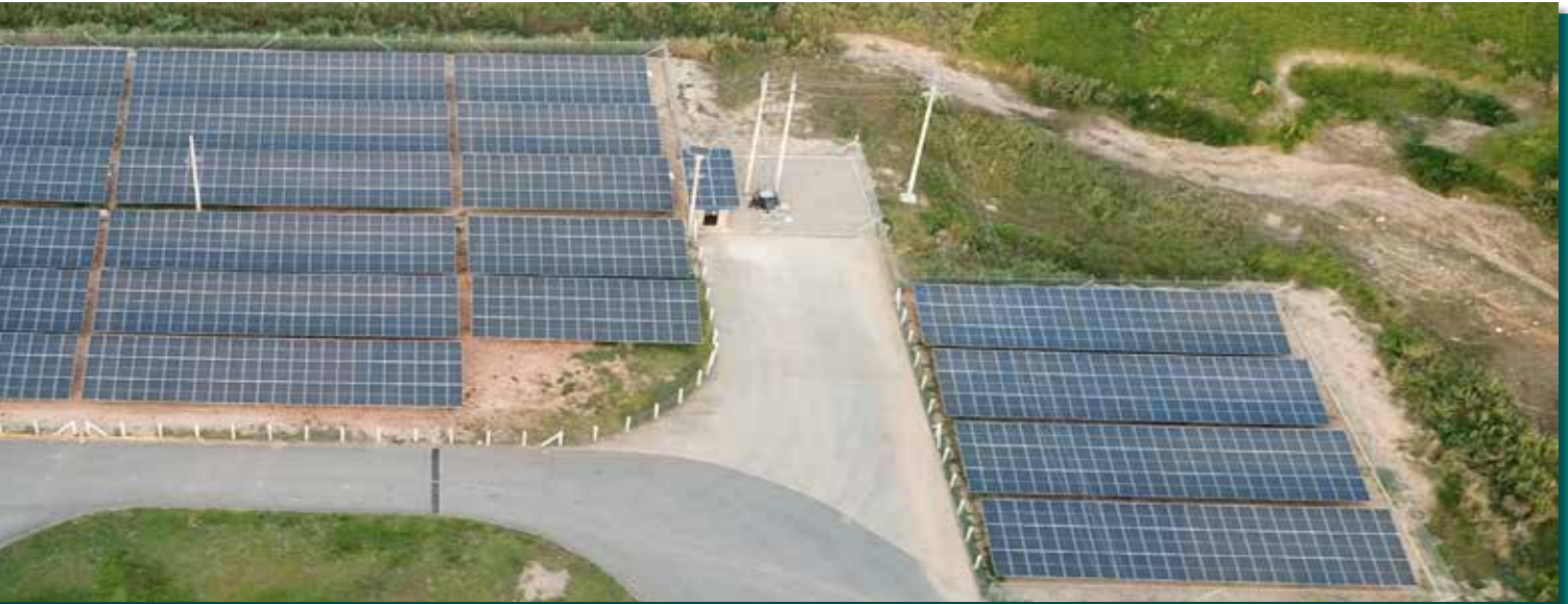
PLANTA DE SECAMINETO, ALMACENAMIENTO Y TRILLA Kilómetro 67 Vía Yopal - Pore
