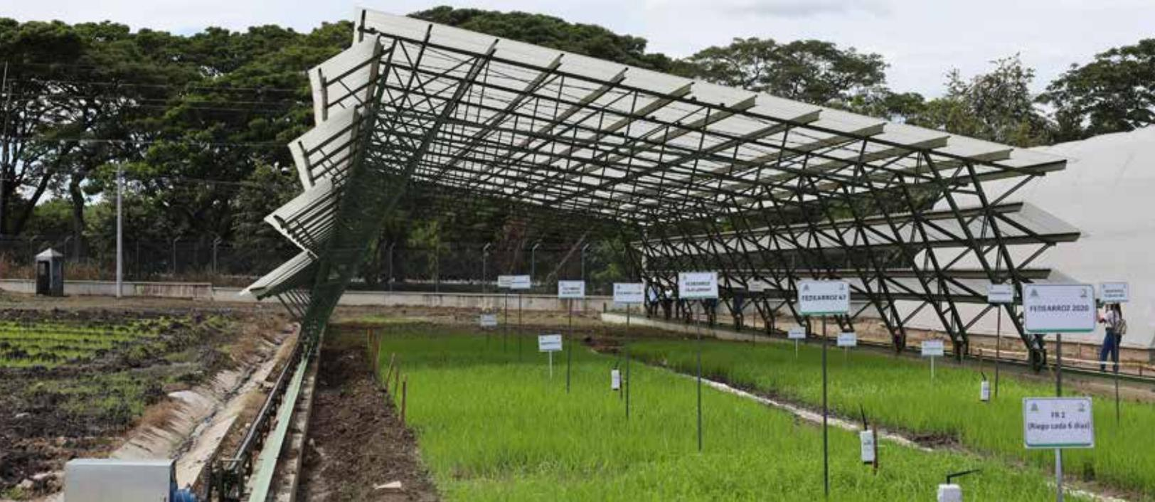
Por otro lado, una de sus estructuras destacadas por su tamaño es el Rain-out shelter, de aproximadamente 1.000 m<sup>2</sup>, dotado de un techo corredizo automatizado e inteligente, que se desplaza por sí solo si es necesario, activado por las gotas de lluvia.
