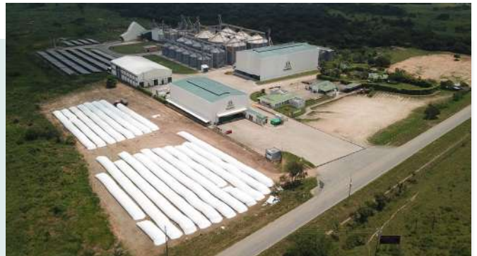
Planta de Secamiento, almacenamiento y Trilla / Pore - Casanare
