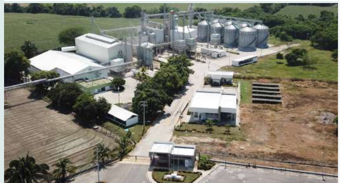
Planta de Secamiento, almacenamiento y Trilla El Espinal - Tolima
