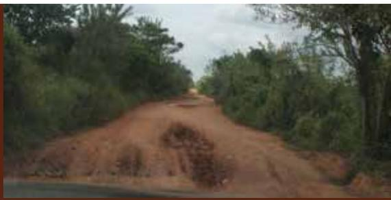
Imagen del carreteable y dique San Jacinto- Colorao (Nechi-Antioquia) 25-30 Km, Carreteable hecho con un material diferente, se encuentra en mal estado. Presenta erosión en diferentes puntos del recorrido.
