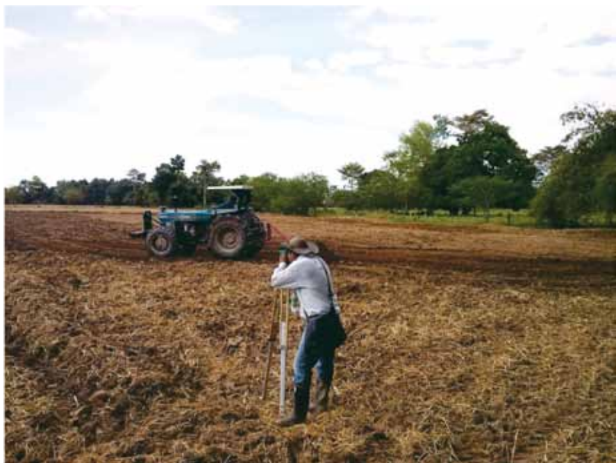
Construcción de piscinas mediante planos de altimetría. Finca Los Mangos, vereda San Pedro Sabana de Torres, Santander
